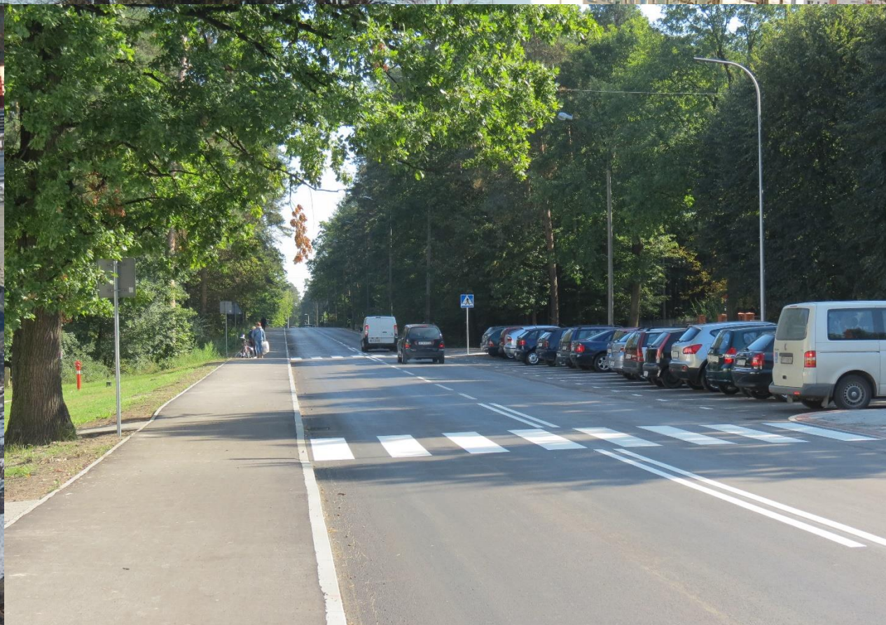
Przebudowana część ulicy Kościuszki
