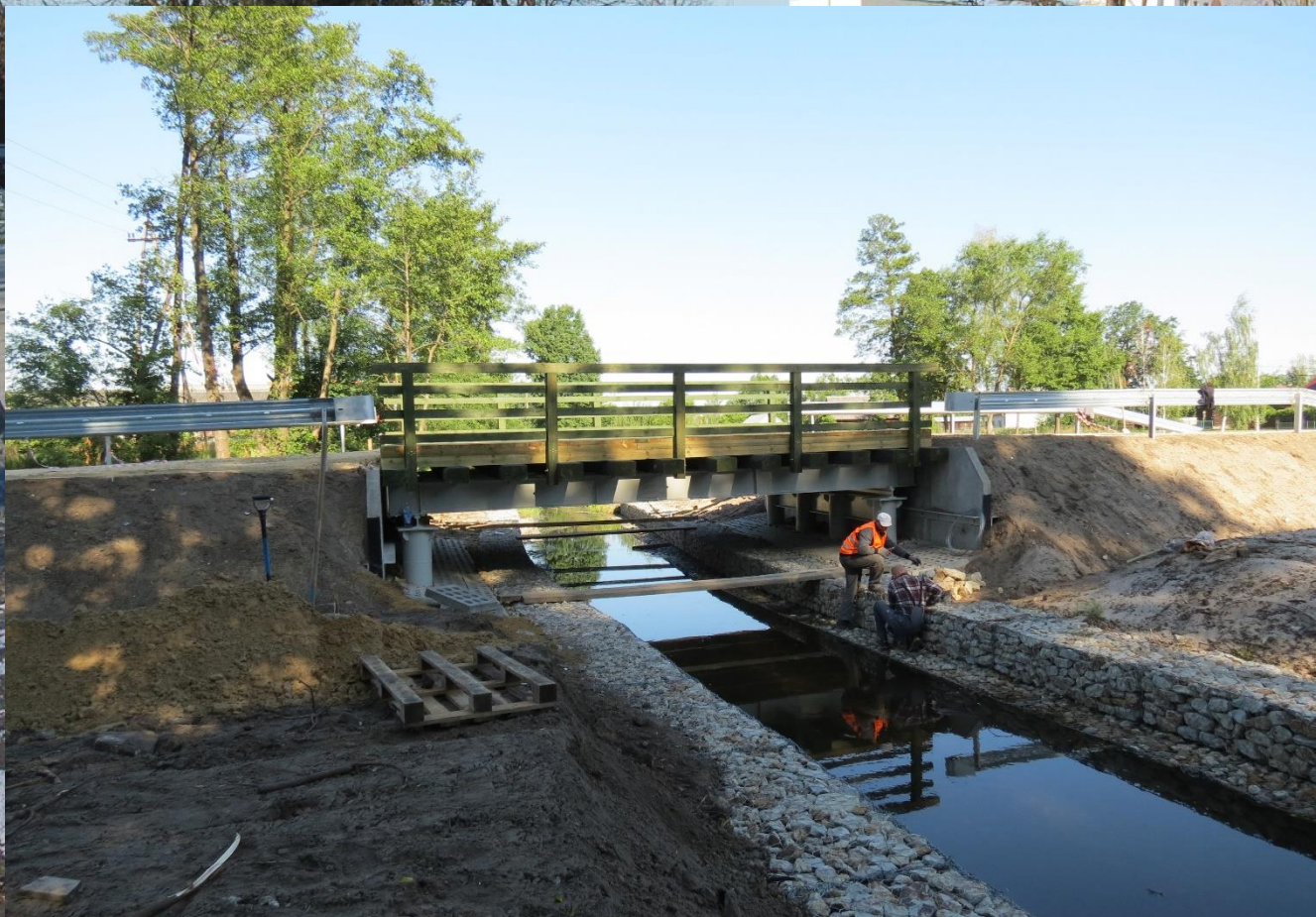
Nowy most w osiedlu Dęba
