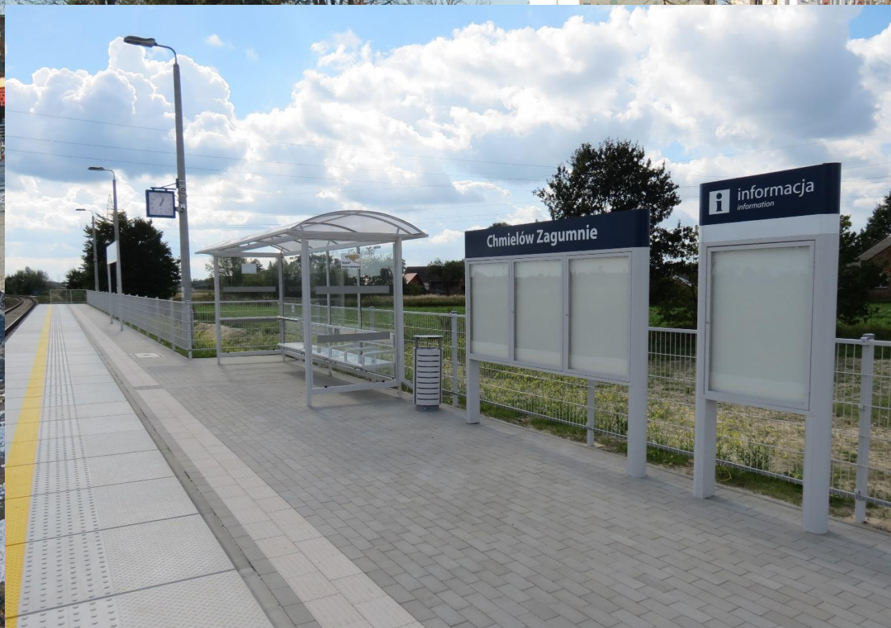
Nowy przystanek kolejowy w Chmielowie
