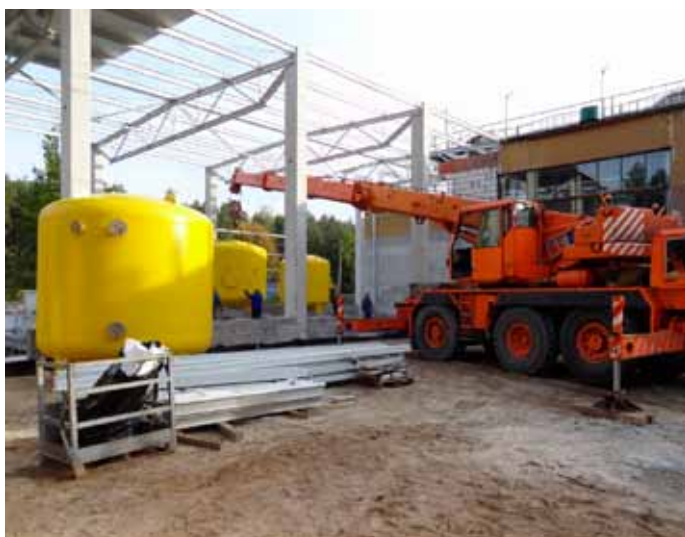
Montaż zbiorników na Stacji Ujęcia Wody
