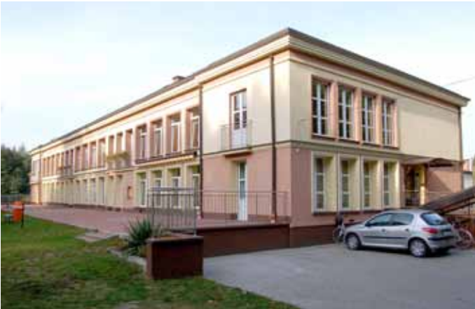
Przedszkole nr 5 po termomodernizacji
